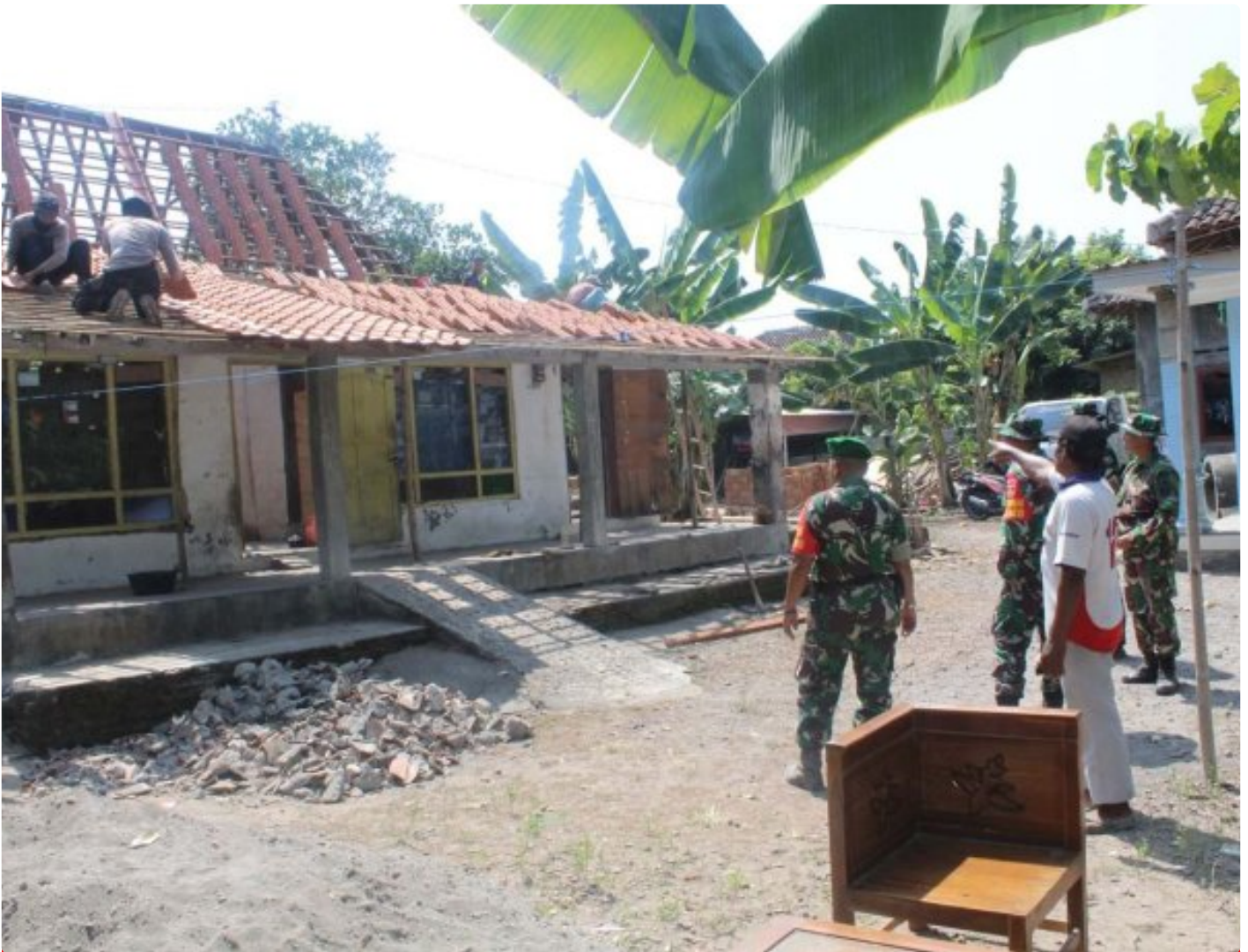
Komandan Satgas TMMD Reg 121 Tinjau Rehab RTLH
